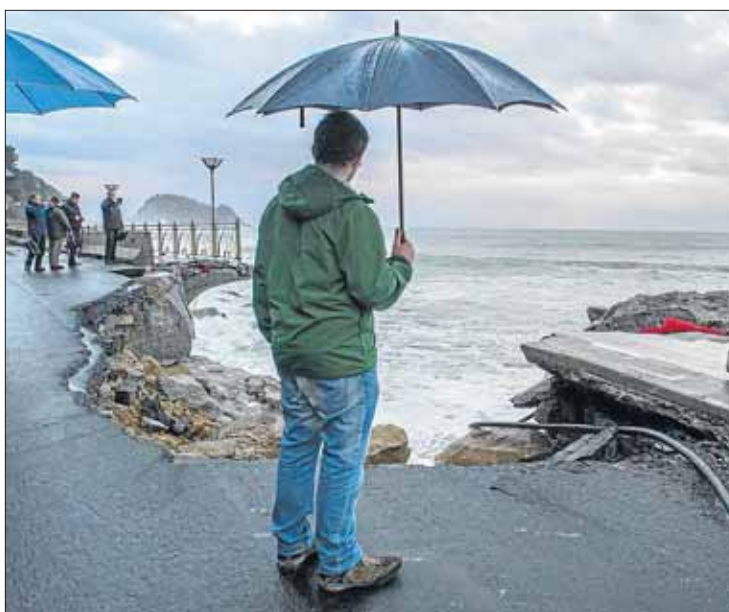
La carretera, destrozada por las olas cerca de Zarautz. Gorka RUBIO | ARGAZKI PRESS
