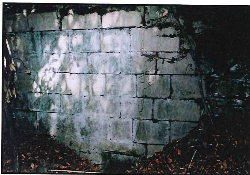
Muro de sillería de la fuente-manantial.
