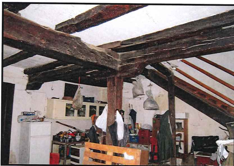
Estructura interior de madera.
