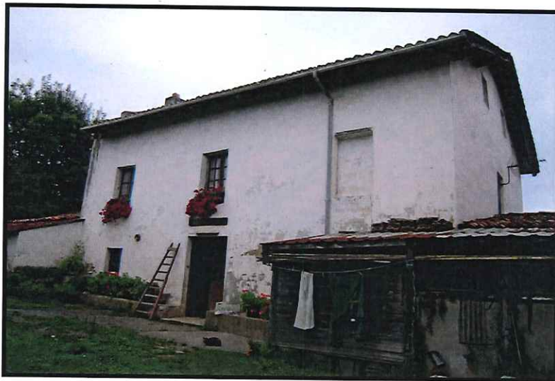
Fachada Sur del caserío.
