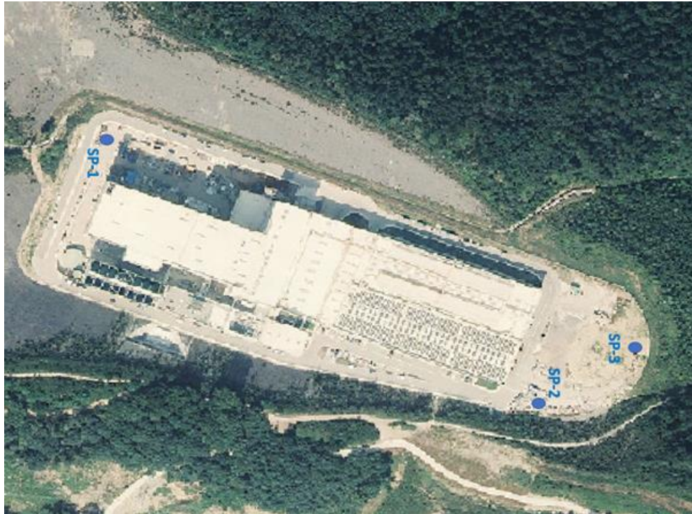
Figura 2. Ubicación de los piezómetros instalados en campañas anteriores
