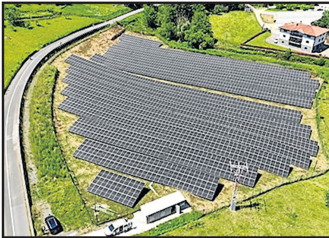
Imagen aérea de la planta solar fotovoltaica de Azpeitia, en el barrio de Urrestilla. KREAN
